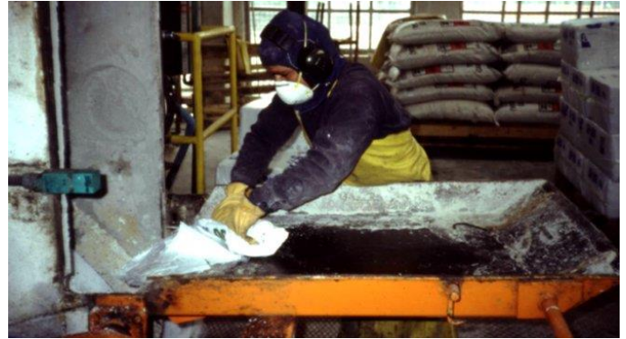
Figura 5.3. Este trabalhador está enchendo uma calha com asbesto que será direcionada até uma pia onde será misturado ao cimento/concreto. Este é um trabalho muito perigoso que coloca o trabalhador em risco de morrer por câncer ou alguma doença pulmonar. A máscara e proteção que ele está utilizando não é apropriada ou eficaz contra a poeira de asbesto, e desta maneira o trabalhador e seu supervisor pensam que a proteção é adequada, quando na verdade isto não ocorre. O asbesto jamais deveria ser utilizado. (Foto por Fernanda Giannasi, fornecida como cortesia por René Mendes – Universidade Federal de Minas Gerais – aposentado, Brasil)
