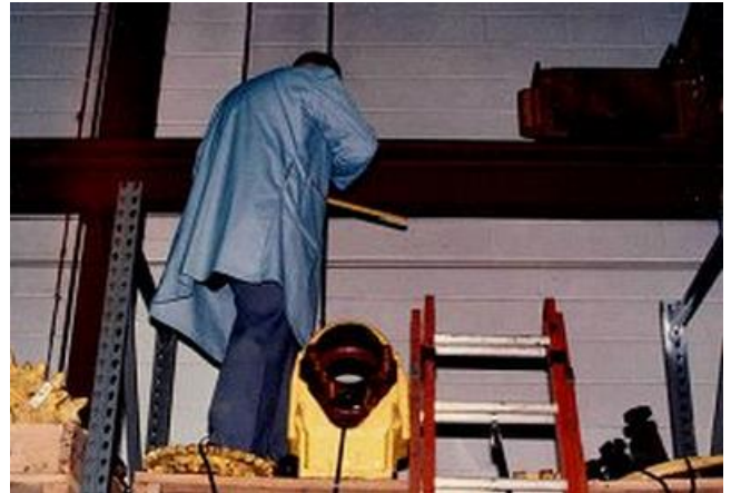
Figura 2.2. Esse trabalhador está completamente desprotegido, em uma plataforma elevada, sem guarda-corpo. A escada também é muito curta e há desordem na passagem que poderia facilmente fazê-lo tropeçar e cair no piso de concreto abaixo. Se ele cair de cabeça a partir desta altura, o dano cerebral poderia ser permanentemente incapacitante. (Foto cortesia de Julietta Rodríguez-Guzman, Universidad El Bosque.)
