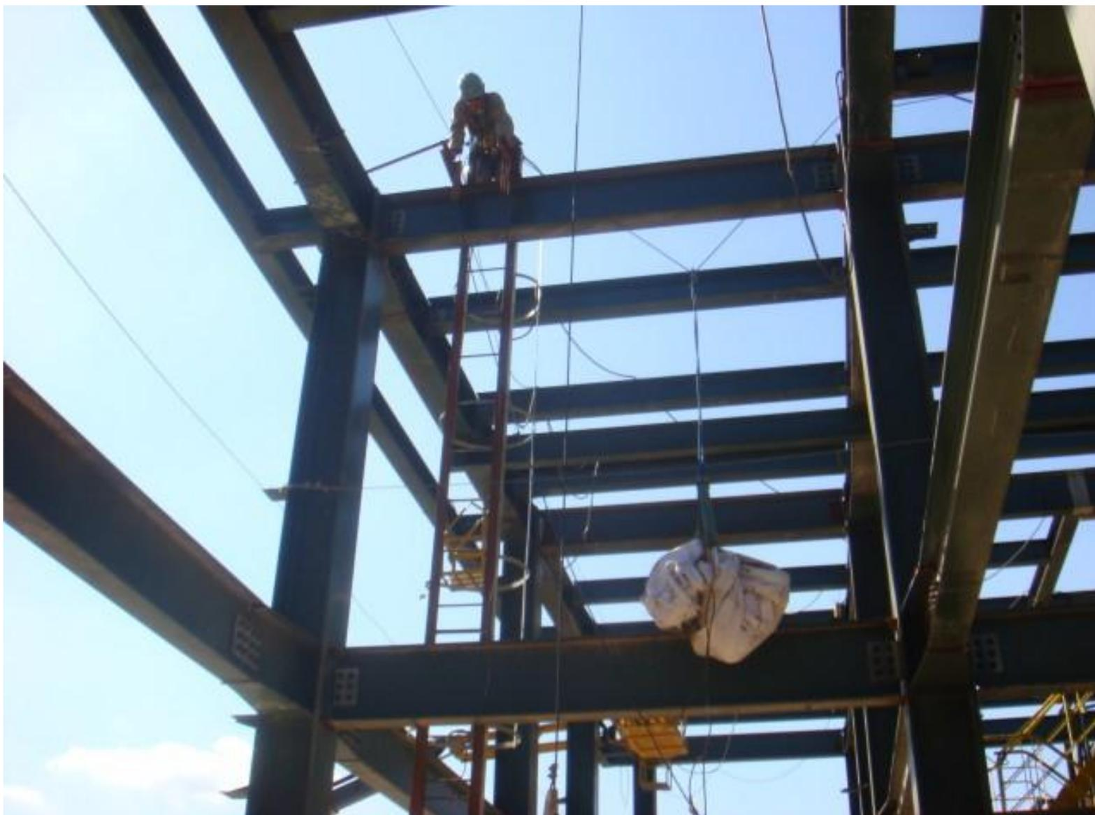
34.6.3.3 **O cinto de segurança** deve ser do tipo paraquedista, dotado de dispositivo trava-queda e ligado a cabo de segurança independente da estrutura onde se encontra o trabalhador.
